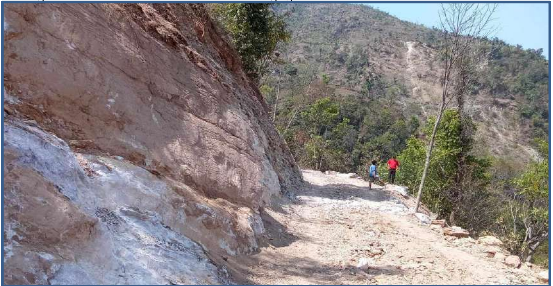
डङ्वा खोलाङ्जे टोङ्के मोटरबाटो निर्माण (बरेङ-१, धुल्लुबाँस्कोट)
