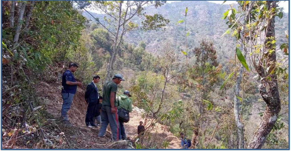
डङ्वा खोलाङ्जे टोङ्के मोटरबाटो निर्माण (बरेङ-१, धुल्लुबाँस्कोट)
