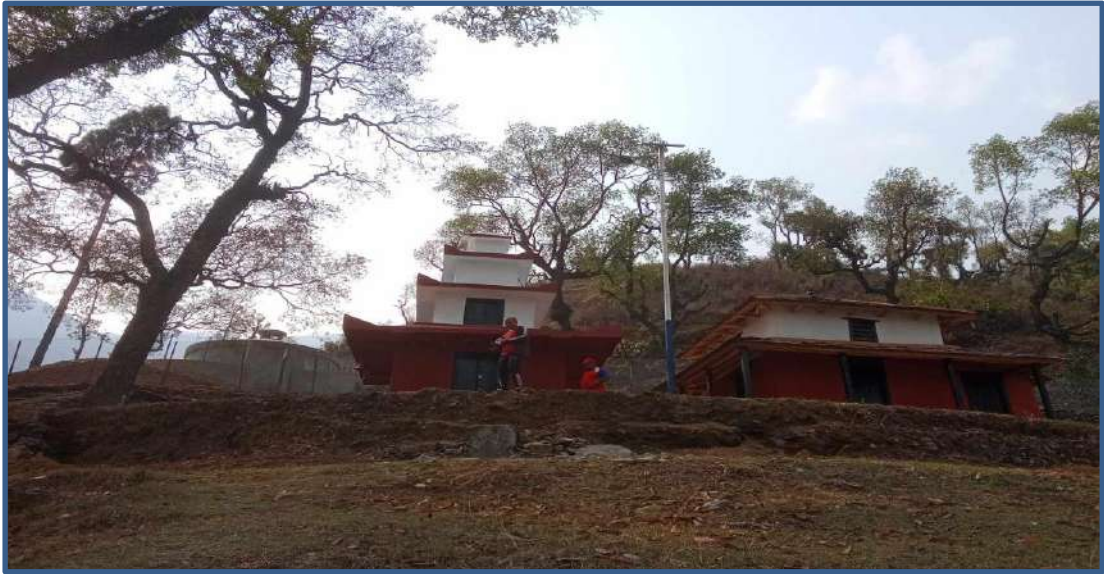
खाल्ले छत्र मन्दिर निर्माण तथा घेराबार, बाटाकाचौर
