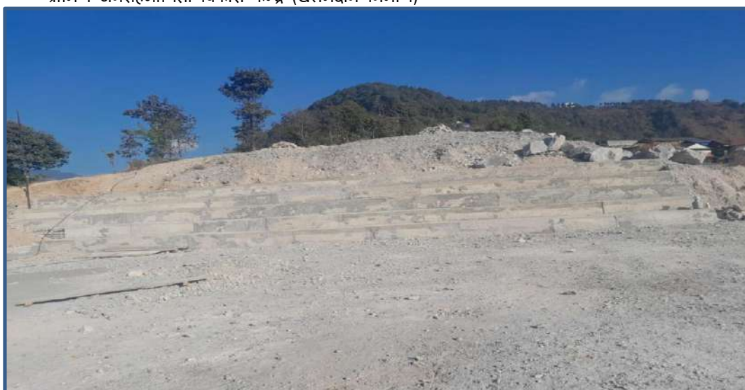
ग्रामिण जनसहभागिता विकास केन्द्र (खेलमैदान निर्माण)
