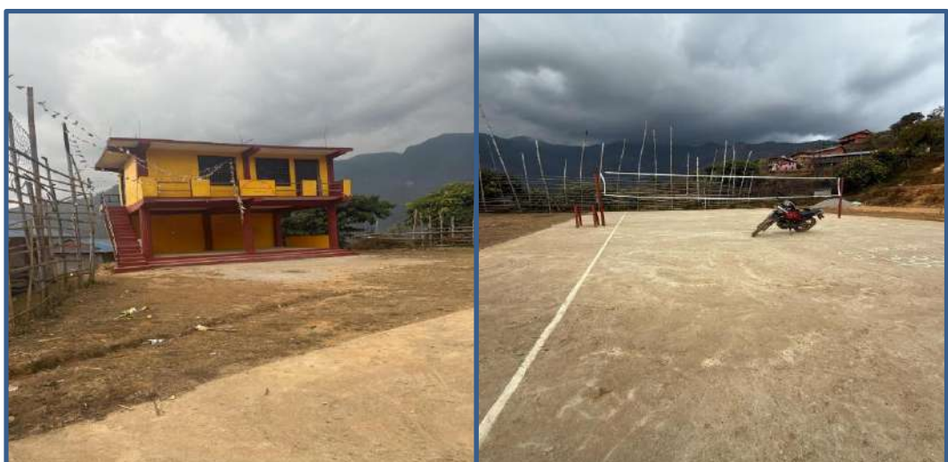
ग्रामिण खेलमैदान स्तरिन्नती (सर्भे)
