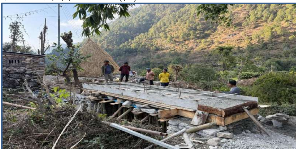
काफलबोट कल्भर्ट निर्माण
