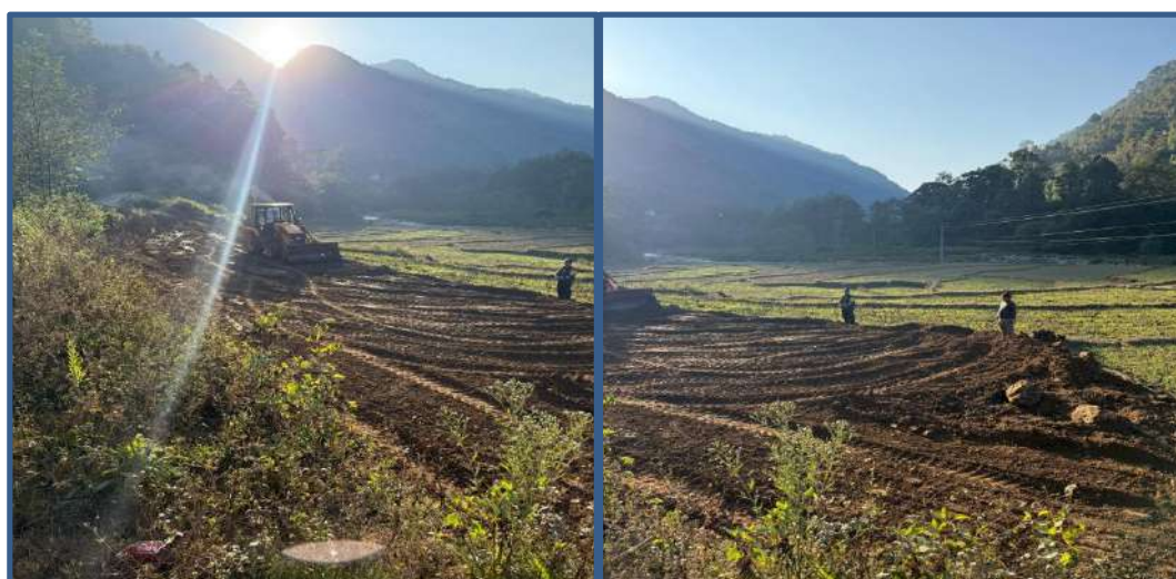
घट्ट सामुदायिक भवन निर्माण(सर्भे)
