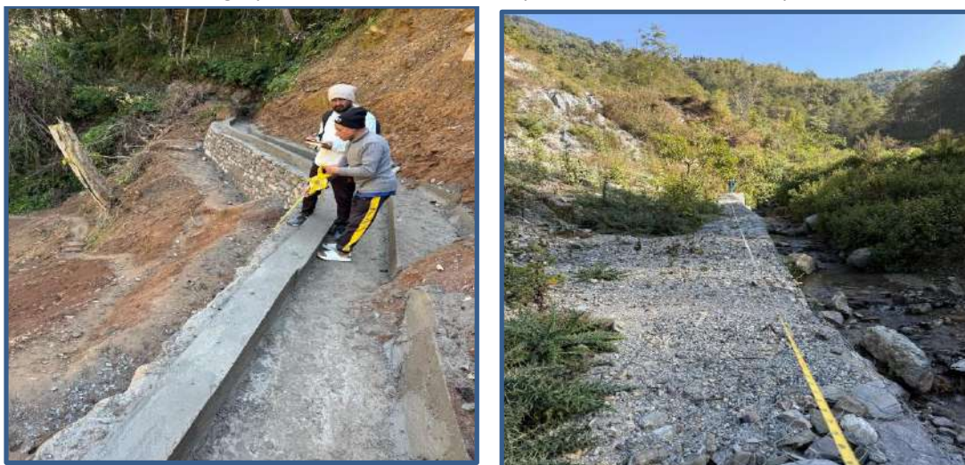
आरुबोट कुलो मर्मत (नाँपजाँच) र वडा स्तरीय खेलमैदान (सर्भे)
