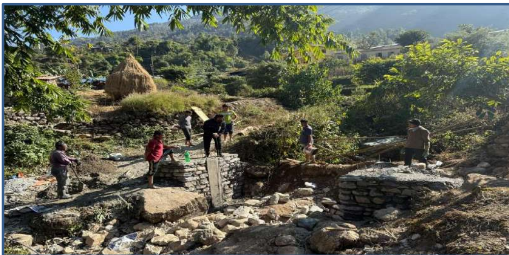
काफलबोट कल्भर्ट निर्माण
