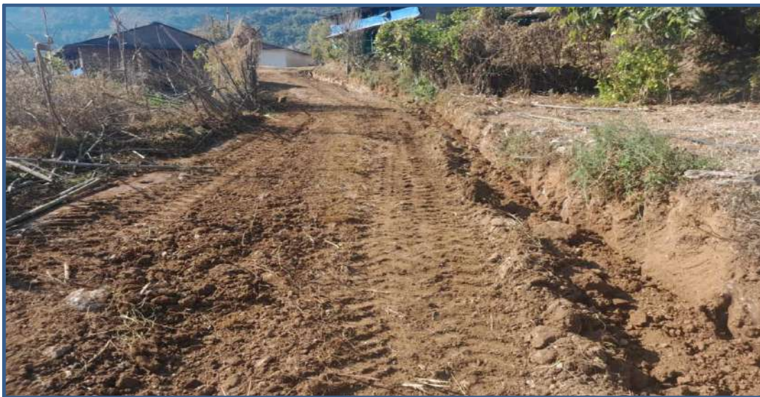
उर्लेनी ठाकुरचौर मोटरबाटो स्तरोन्नती (कच्ची नाली र लेभलिङ)
