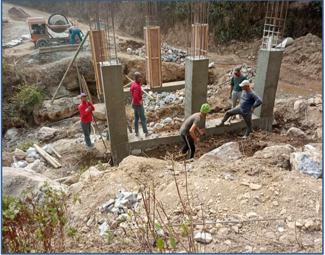
गैढुंगा खोला पुल निर्माण
