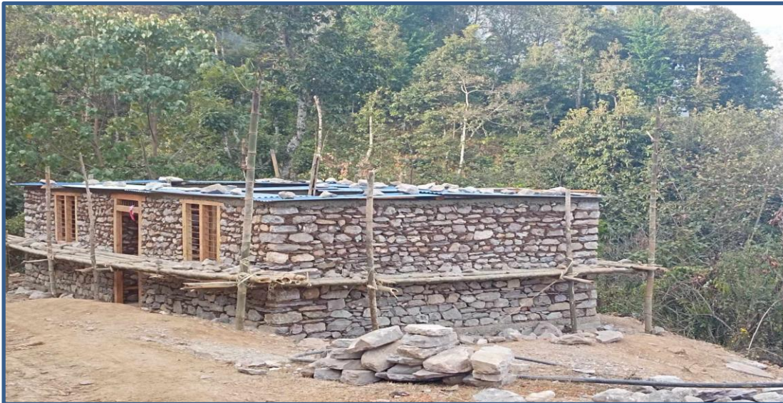
ठुलादलेङ सामुदायिक भवन तथा शौचालय निर्माण (निर्माणाधिन)
