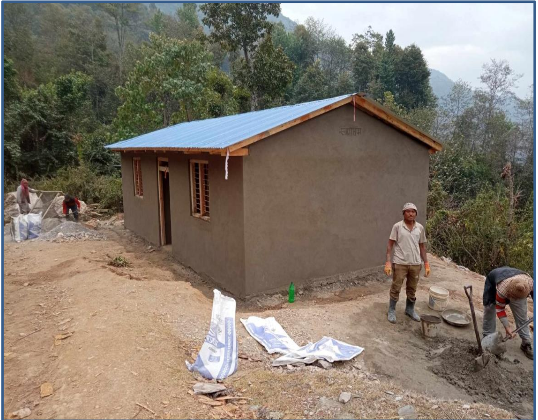
ठुलादलेड सामुदायिक भवन तथा शौचालय निर्माण (निर्माणाधिन)
