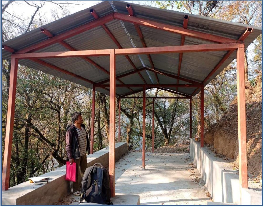
भुमेथान ट्रस निर्माण
