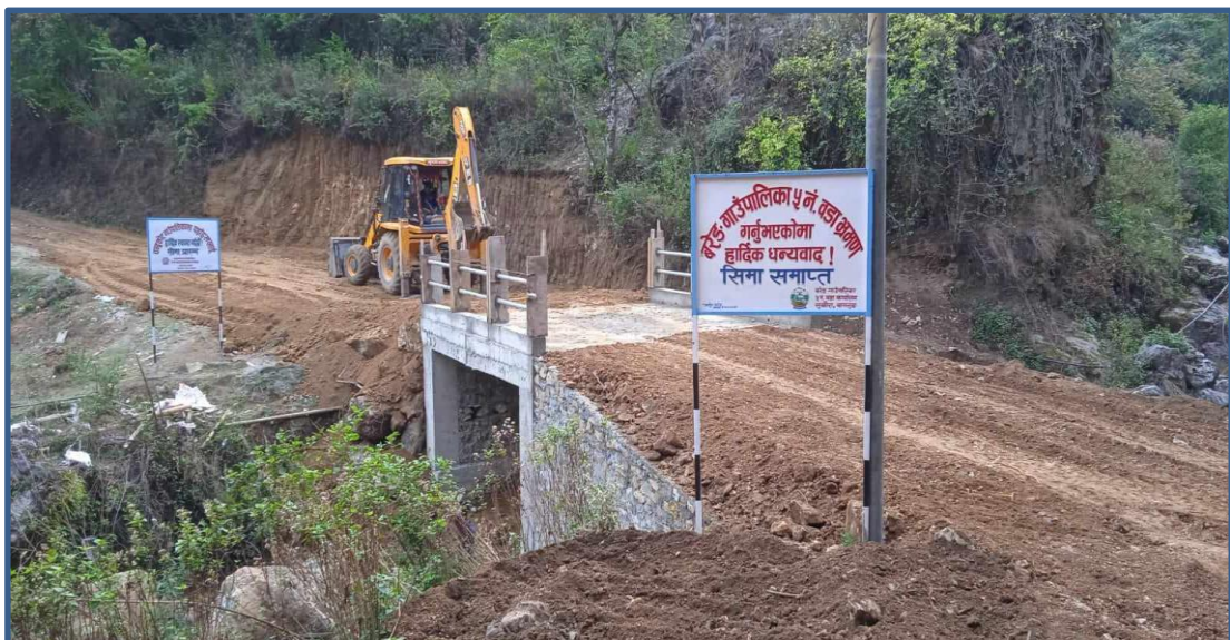
गैदुंगा खोला पुल निर्माण (चन्द्रकोट गा.पा. साझेदारी)-सुखौरा
