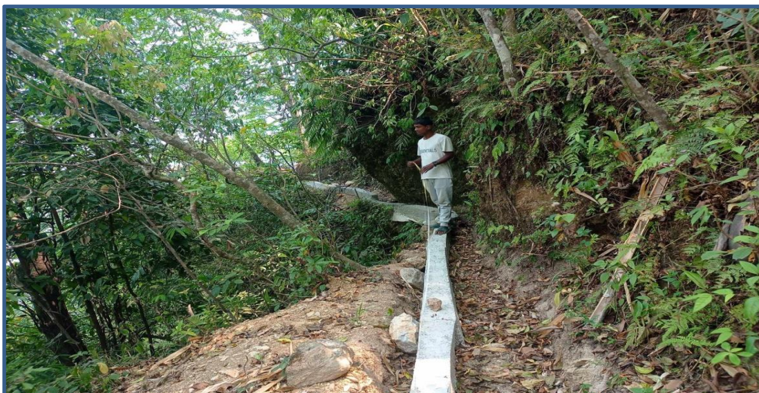
आसामारे कापरात सिंचाई कुलो निर्माण, बरेड-१ धुल्लुबाँस्कोट
