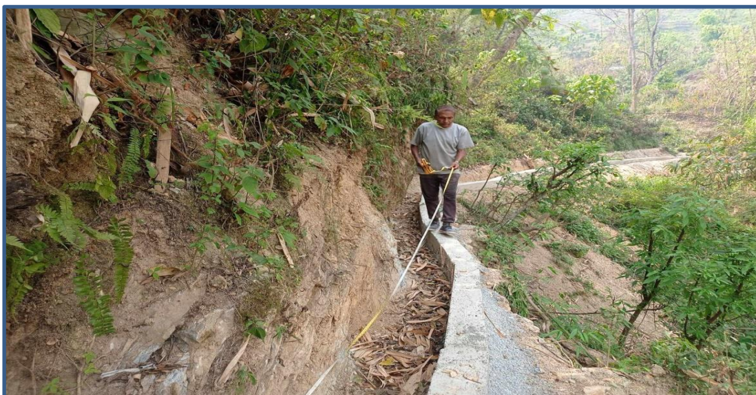
आसामारे कापरात सिंचाई कुलो निर्माण, बरेड-१ धुल्लुबाँस्कोट
